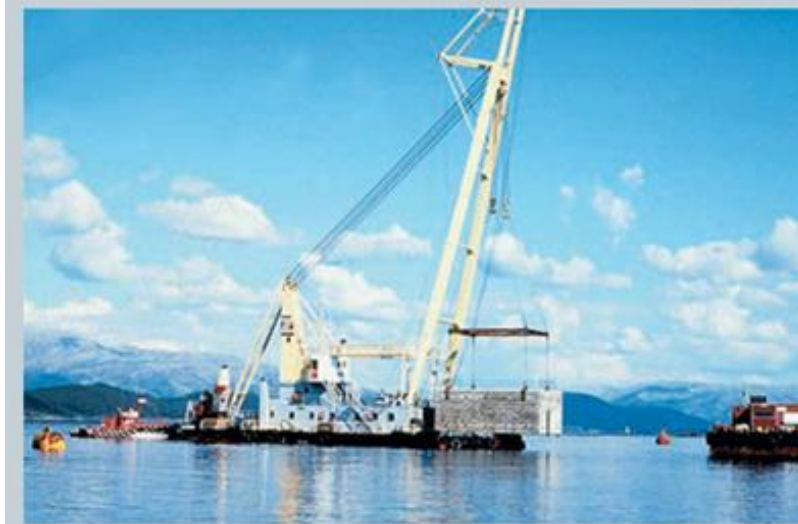
При дубинама већим од око 4m бунар се спушта са скеле или пловила
