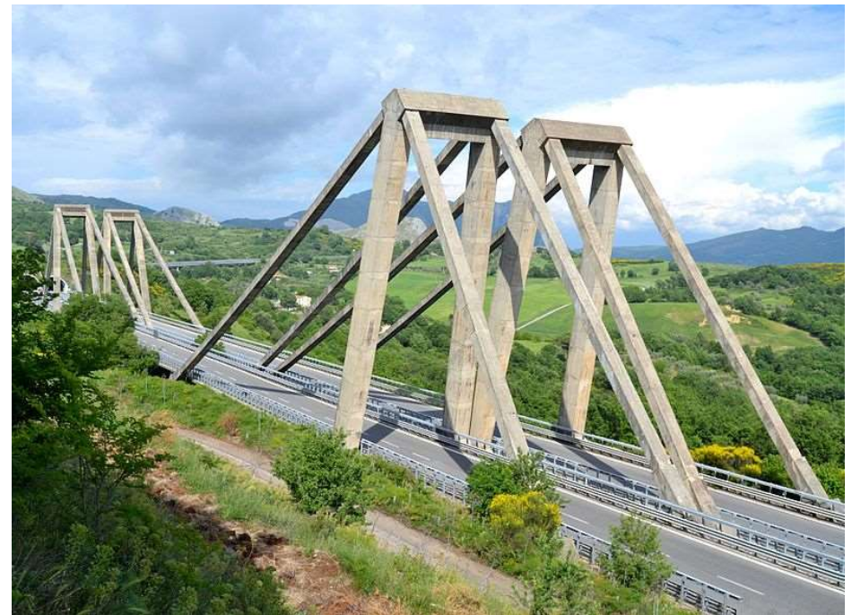
Viadotto_Carpineto 30.00 m - 181.00 m - 30.00 m
