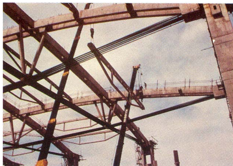
Montaža sek. nosača
