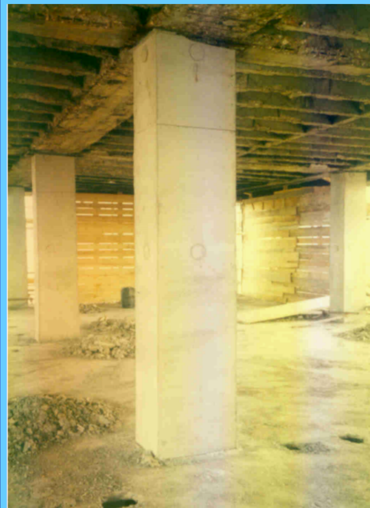
Izgled saniranog stuba
