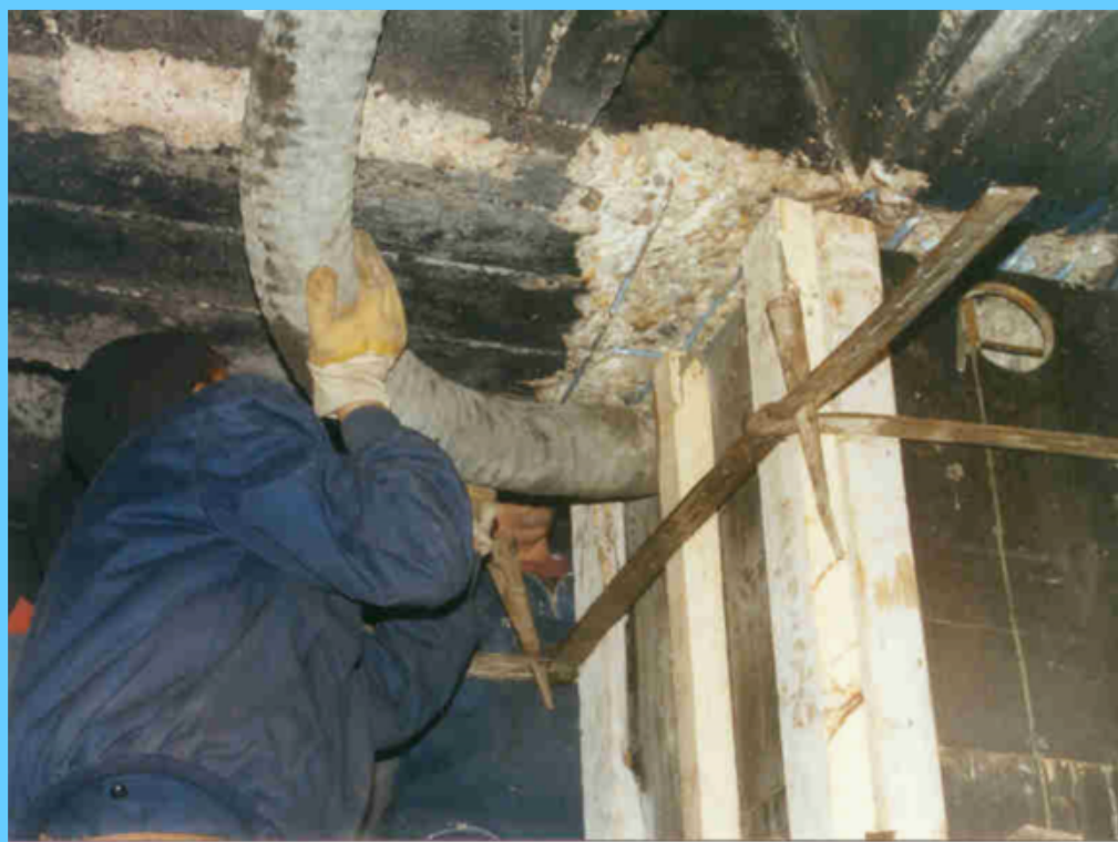
Betoniranje dodatne obloge
