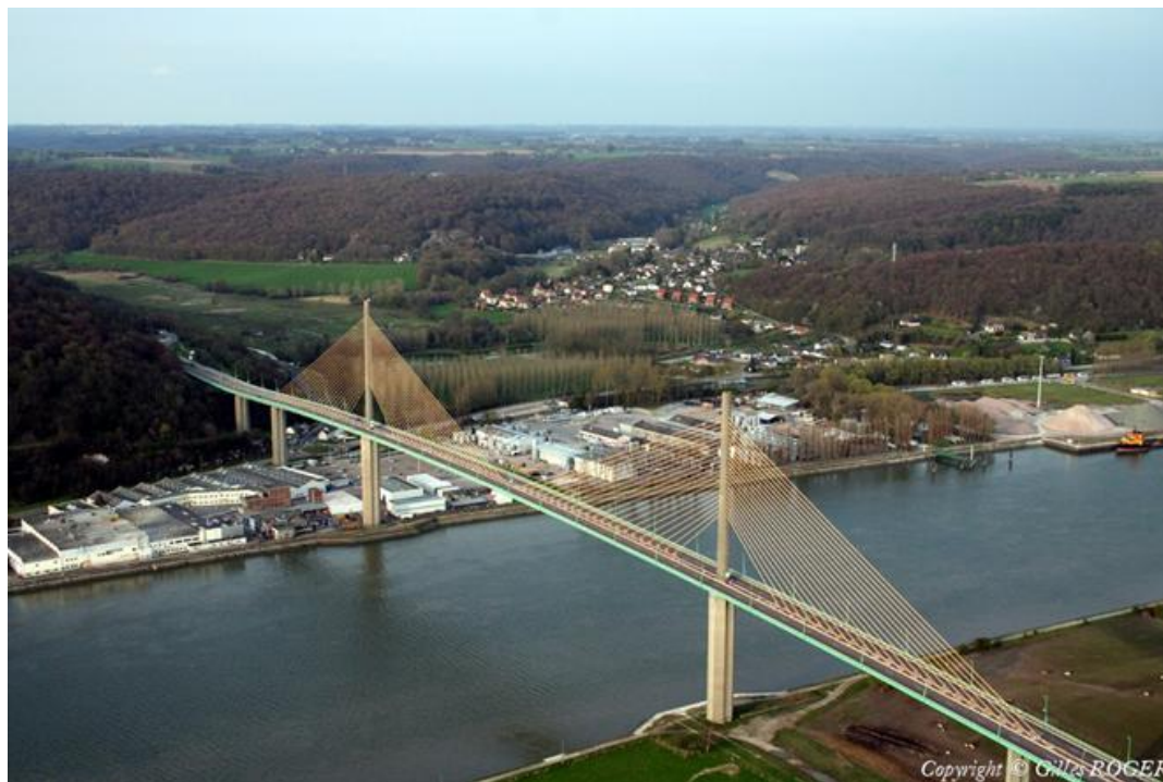
Pont de Brotonne
