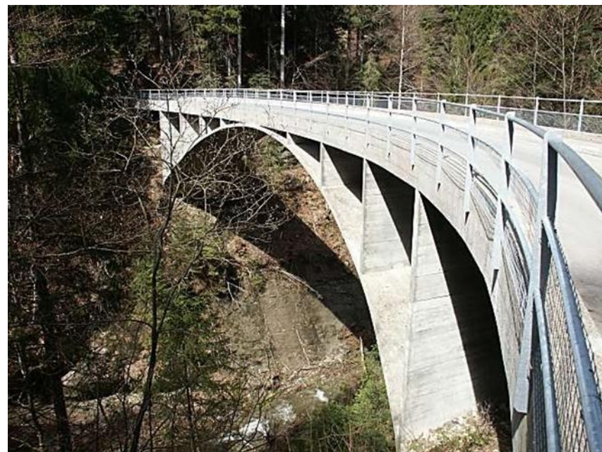
Pont de Schwandbac
