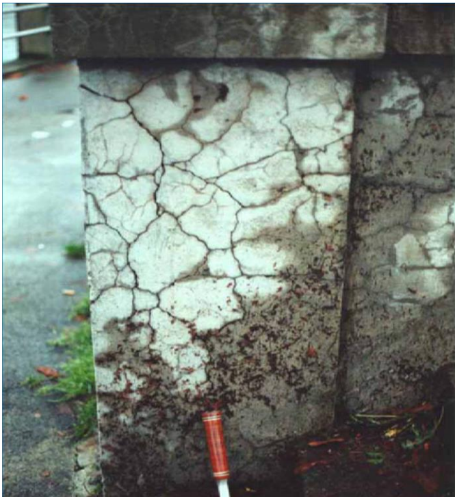
Oštećenja usled alkalno-agregatne reakcije
