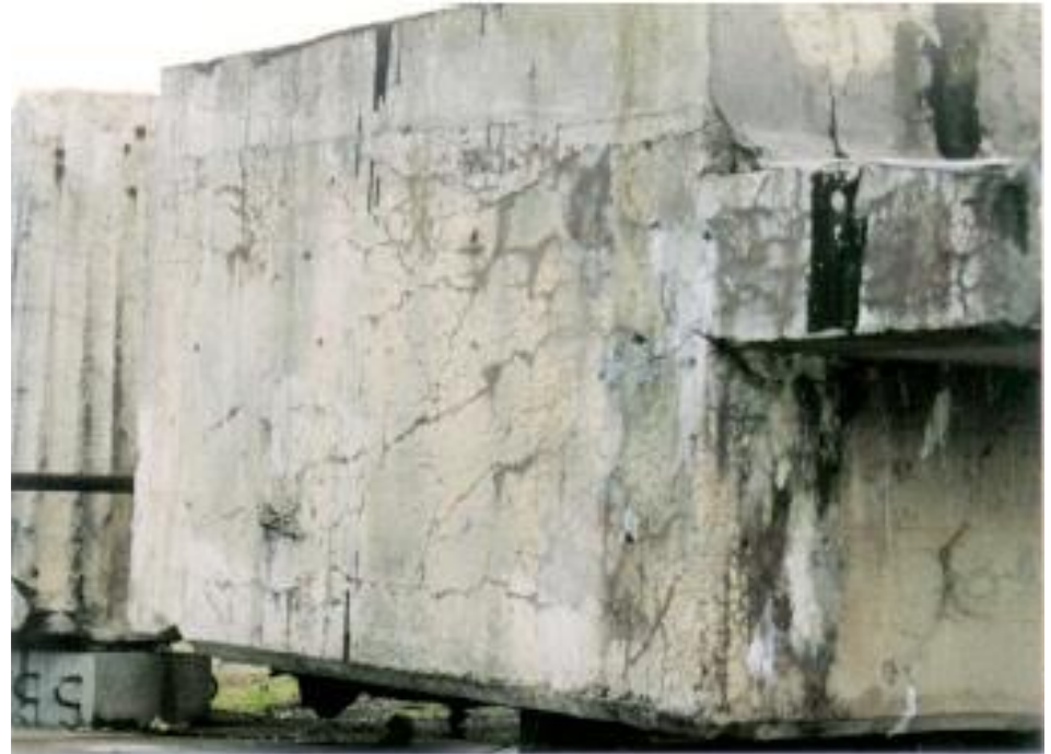
Oštećenja usled alkalno-agregatne reakcije
