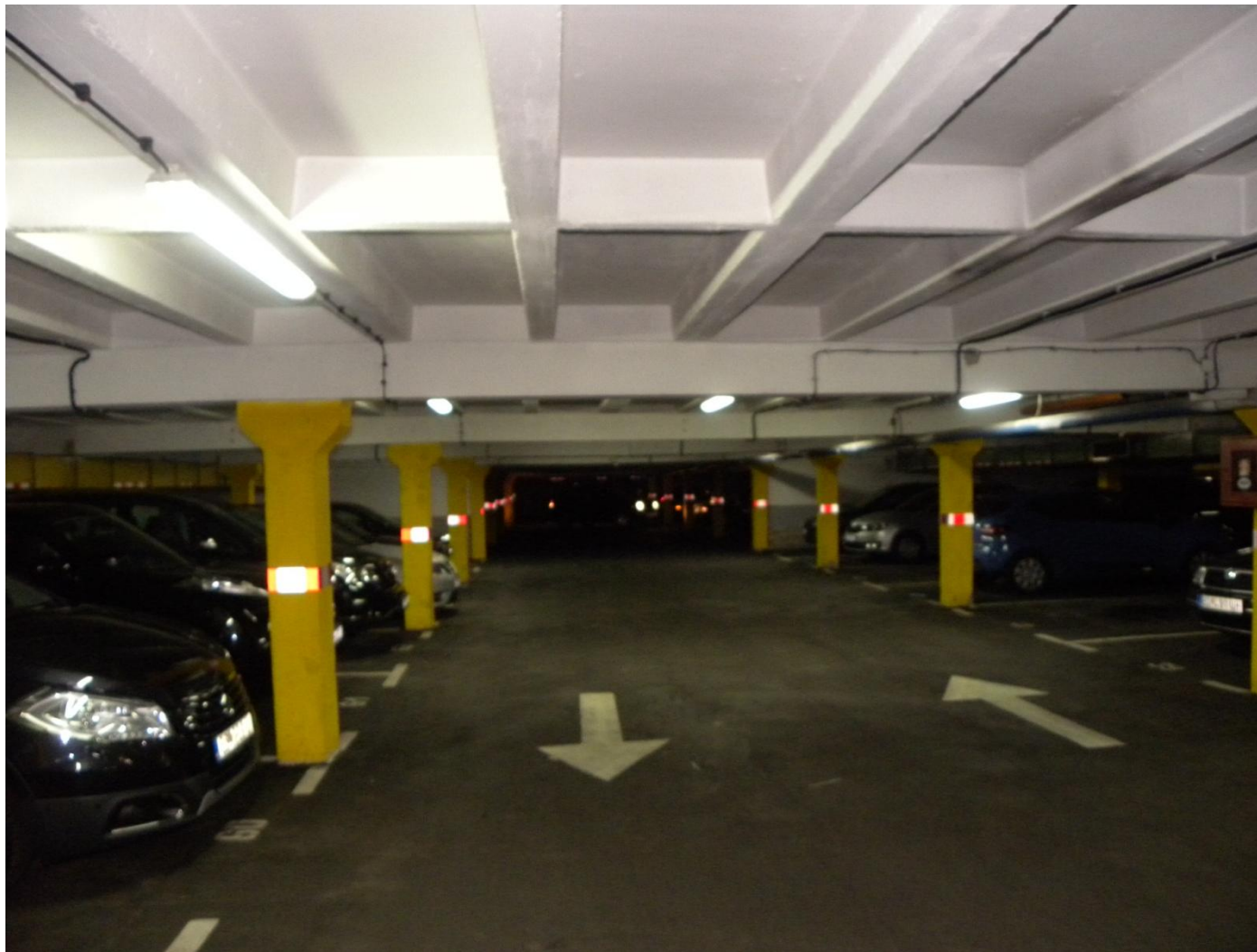
Garaža u Mileševskoj
