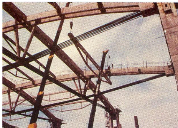
Montaža sek. nosača
